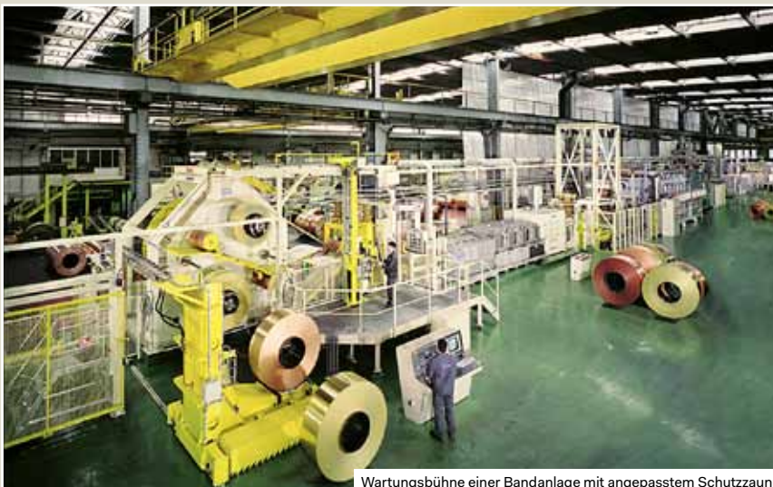
Wartungsbühne einer Bandanlage mit angepasstem Schutzzaun
